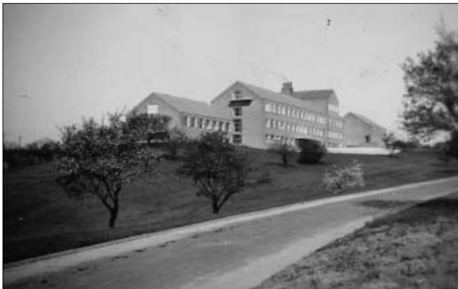
Aarhus Universitets første bygning, nuværende Bygning 340, set fra sydøst 1936. Foto Henning Henningsen. Foto i Universitetshistorisk Udvalgs samling.
