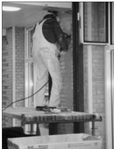
Der indsættes ståltragere i nederste etages murkonstruktion. Optagelse 14. februar 2003 v/ P. Teglborg.
