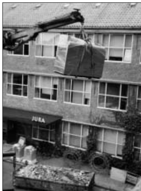
Bogformidlingens kopimaskine fjernes gennem vindueshul af kæmpekran. Optagelse 12. august 2002 v/ P. Teglborg.
